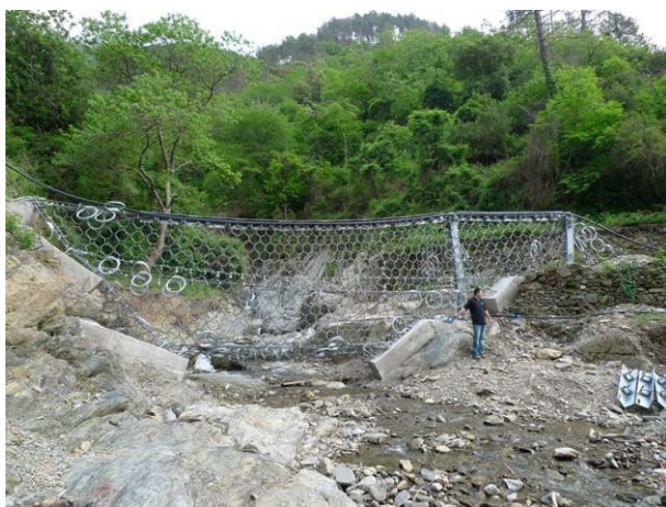
Figura 4 – Esempio di barriera debris flow in fase di realizzazione ed esempio di barriera interessata da evento.
