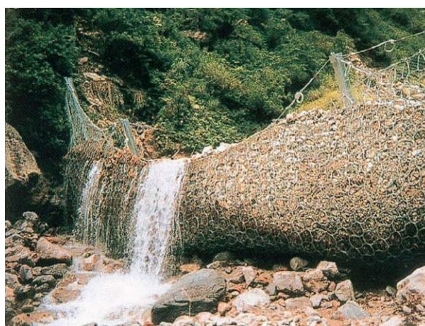
Figura 4 – Esempio di barriera debris flow in fase di realizzazione ed esempio di barriera interessata da evento.
